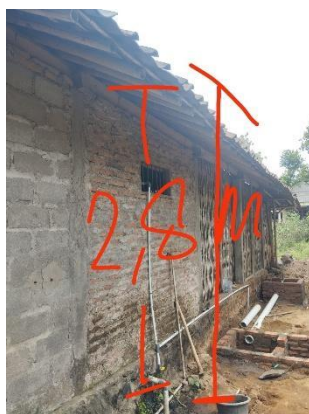
Rencana pemasangan tiang monitoring disalah satu Lokasi di boyolali
