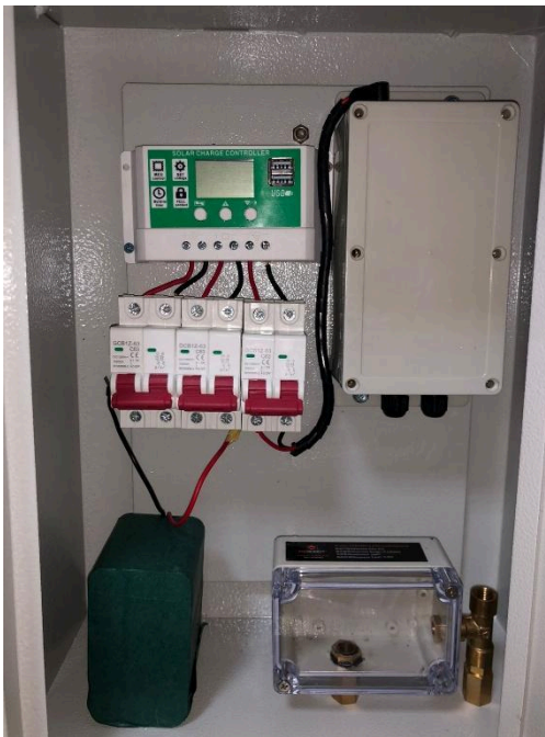
Sistem monitoring, baterai, SCC, dan sensor H 2 S, CO, dan CH 4
