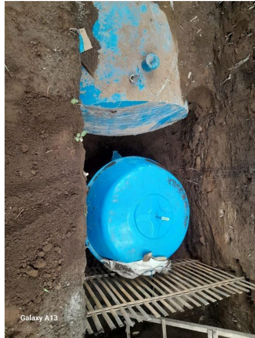
Proses pemasangan kembali biodigester
