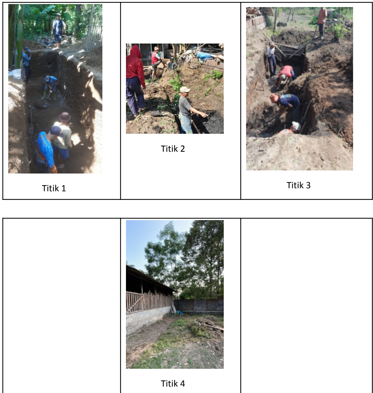
Gambar 6.4 Empat titik penggalian unuk instalasi Biodigester
