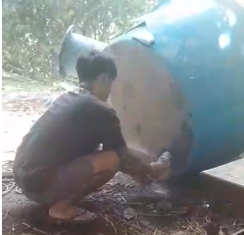
Proses perbaikan biodigester
