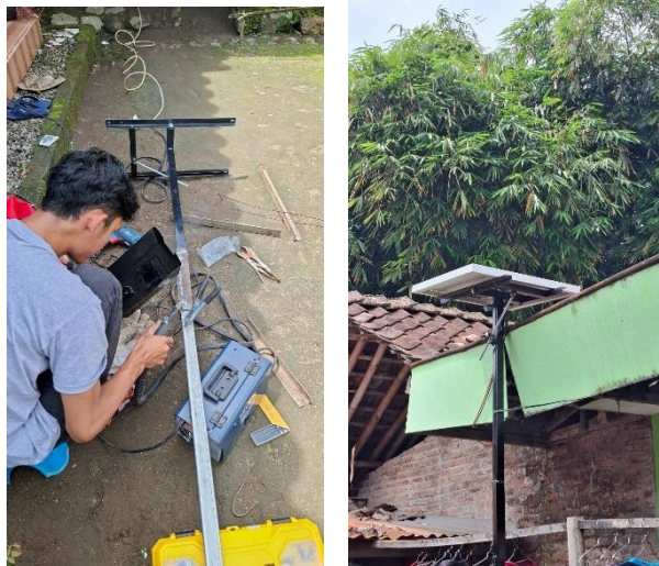
Modifikasi dan pemasangan tiang Panel Surya
